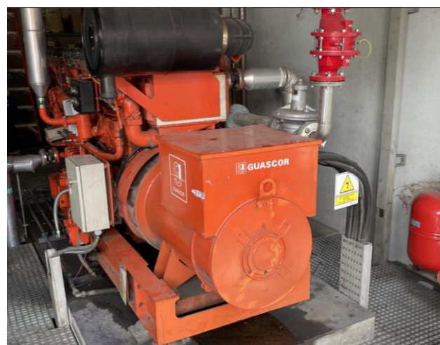
Imagen 1 – Motor n°1 GUASCOR de 300 kWe
