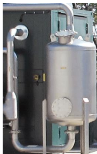
Imagen 6 – Filtro de carbón activo 1.000 litros
