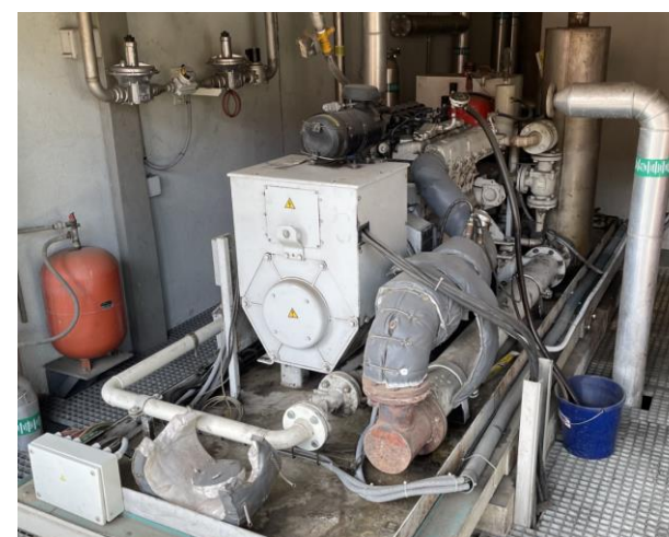
Imagen 2 – Motor n°2 MAN de 60 kWe
